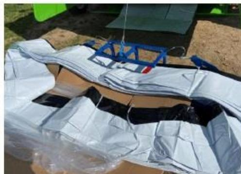
Figure 39. Installation du sac sur le grappin
